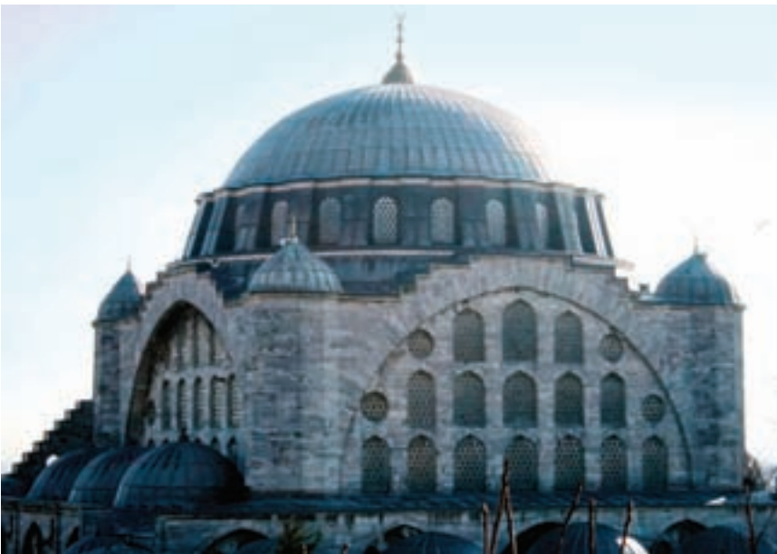
Sinan'ın en iddialı yapılarından bir olan Edirnekapı Mihrimah Sultan Camisi'nin yarım kubbelerle desteklenmeyen kubbesini, duvarların içine ustaca gizlenmiş dört fil ayağı taşır ve bunların uzantısı olan ağırlık kuleleri kubbeyi çevreler. Bu sayede duvarlar, içeriyi ışıkla doldurmak için açılmış çok sayıda pencereye kavuşur.
