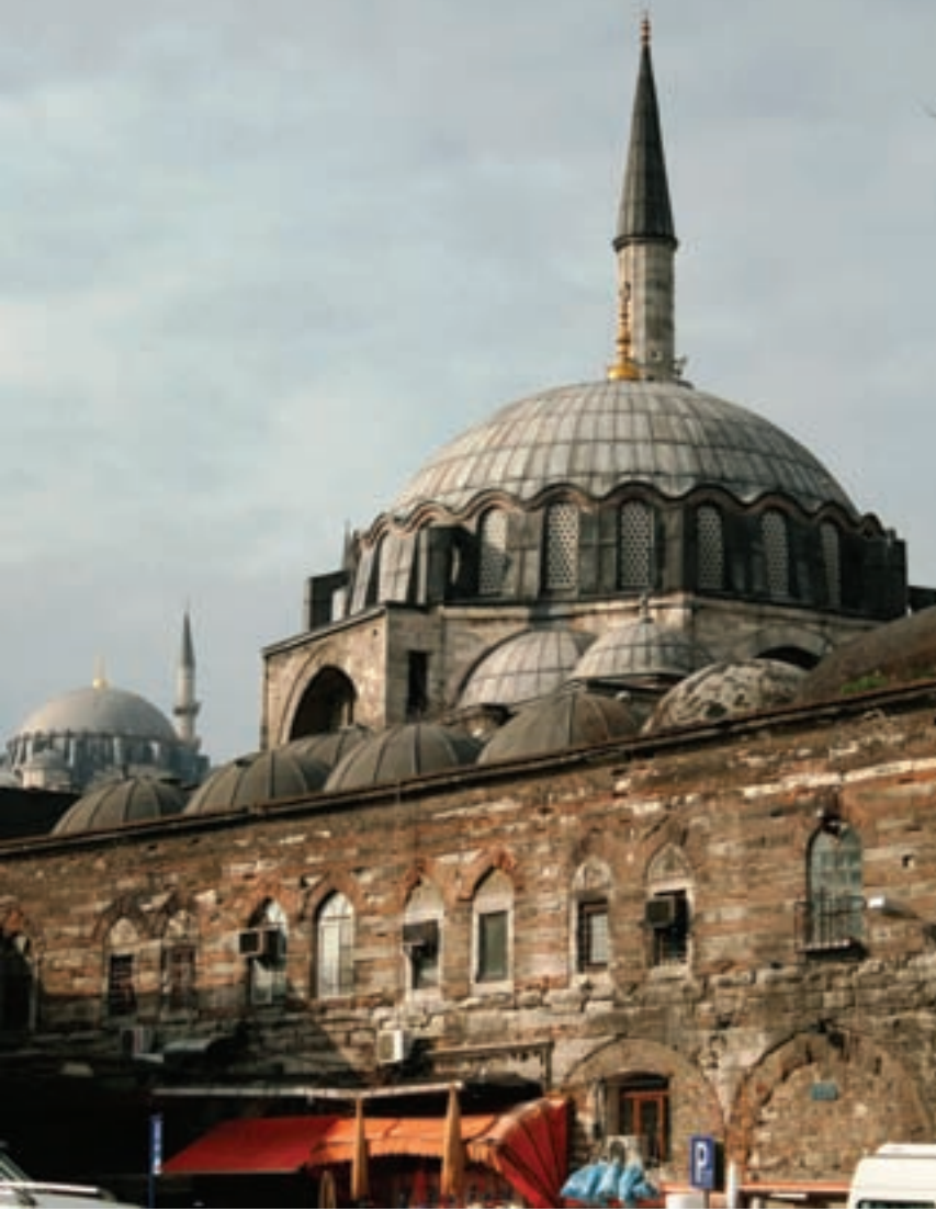
İstanbul Eminönü'ndeki Rüstempaşa Camisi, Sinan'ın farklı mekânlar için bulduğu özgün çözümlere güzel bir örnektir. Yapı, alt kattaki ticaret merkezine yer sağlamak için bir teras üzerinde inşa edilmiştir.
