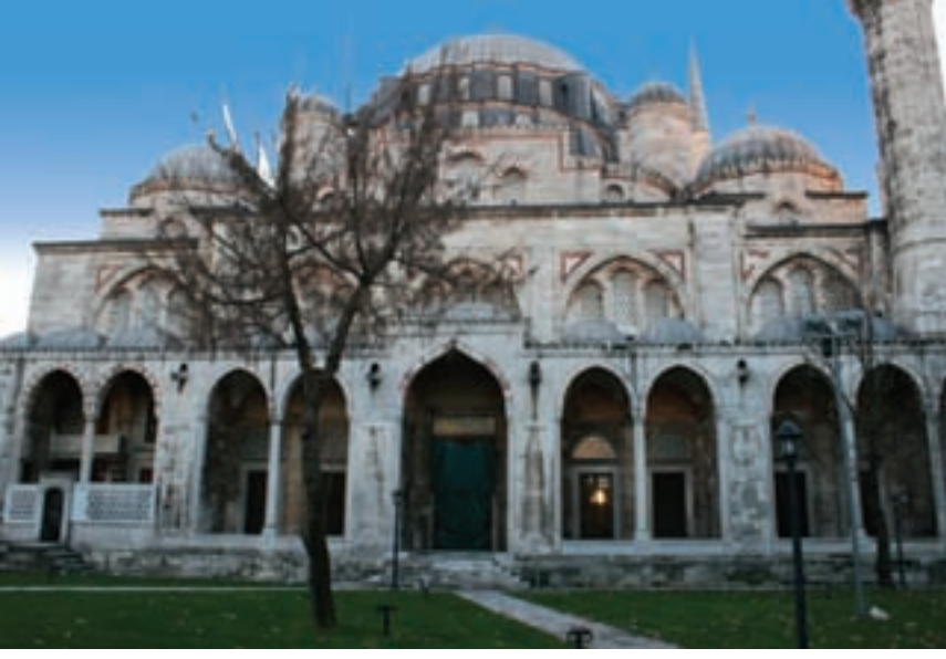
Sinan'ın Osmanlı mimarisine en önemli katkılarından biri, ilk örneği Şehzade Camisi'nde görülen yan galerilerdir. Kubbenin ağırlığını yere kadar ileten payandaların devamı niteliğindeki bu yapılar, cepheye hareketlilik de katar.
