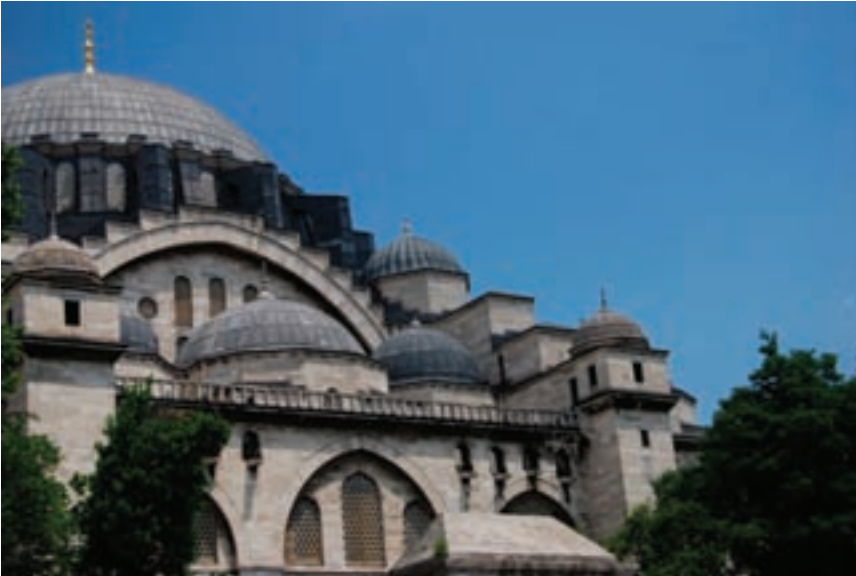
Ayasofya'nın büyük kubbesini destekleyen payandaların hantal görünümünün yerini Süleymaniye'de "kubbeler şelalesi" almıştır. Ağırlık en yukarıdan en aşağıya kadar kademe kademe aktarılırken, yapı bir piramit gibi öne çıkar.
