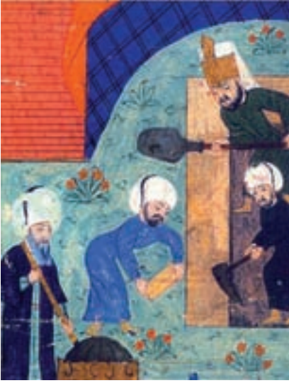
Süleymanname’de yer alan ve Mimar Sinan’ı Kanuni’nin türbesinin inşaatının başında, elinde zira (mimarların kullandığı metre) ile gösteren minyatürden ayrıntı.
