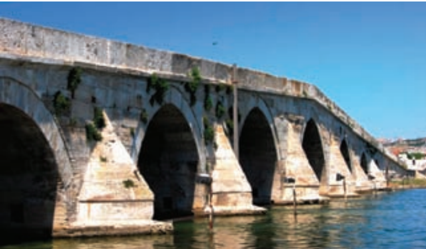
Sinan'ın Büyükçekmece'deki küçük adacıklar üzerine temellerini ahşap kazıklarla sabitleyerek inşa ettiği 636 metrelik köprü, güzelliğiyle bir ulaşım yolu olmaktan öteye geçiyor.
