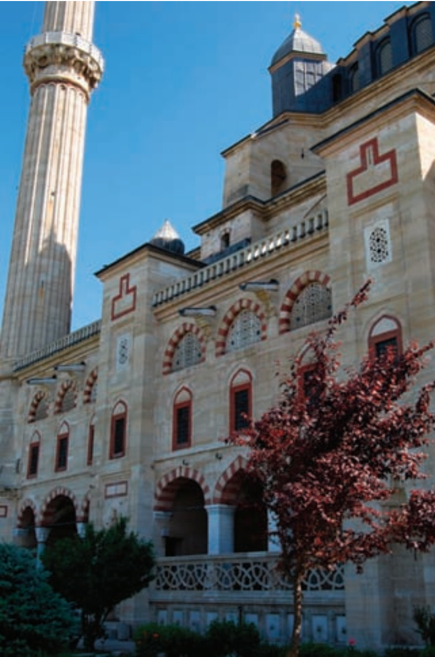
Edirne Selimiye Camisi'nde sadece yan cephelerde değil, kible cephesinde de galeriler kullanılmıştır. Yapının üst bölümlerindeki payandalar aşağıya inildiğinde galerilere dönüşür.
